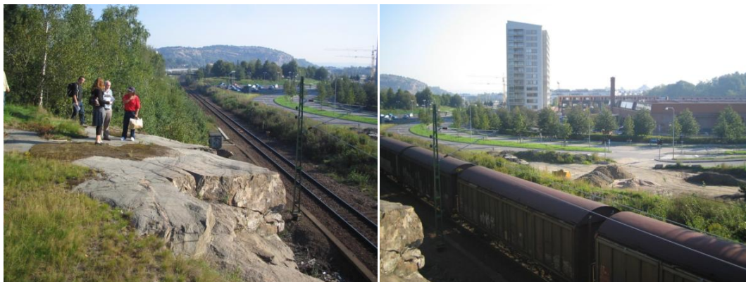
Befintlig hamnbana sedd från området och österut
