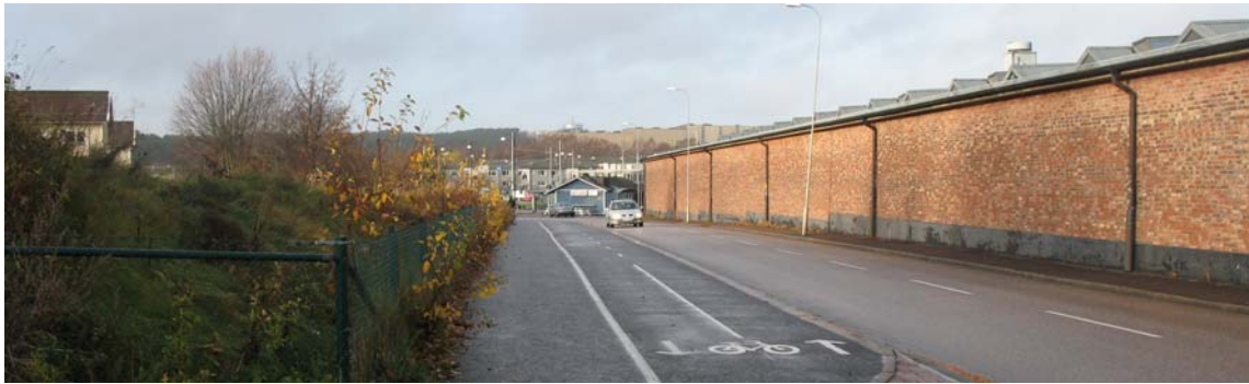
Lång tegelbyggnad längs Fyrväpplingsgatan.
