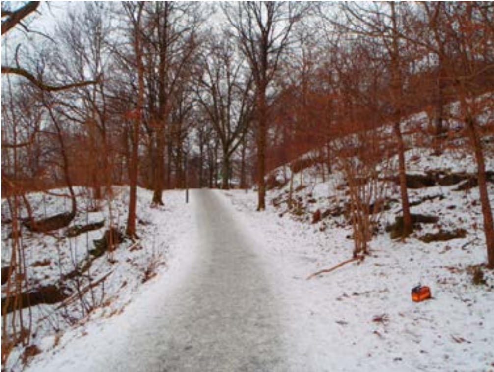
Foto 13. Bernhard Karlgrens Gångväg ovanför eventuell bergschakt. Den norra schaktväggen löper från bildens vänstra sida fram till gångvägen. Den naturliga slänten ovanför gångvägen bedöms idag vara stabil. Bild tagen mot syd.
