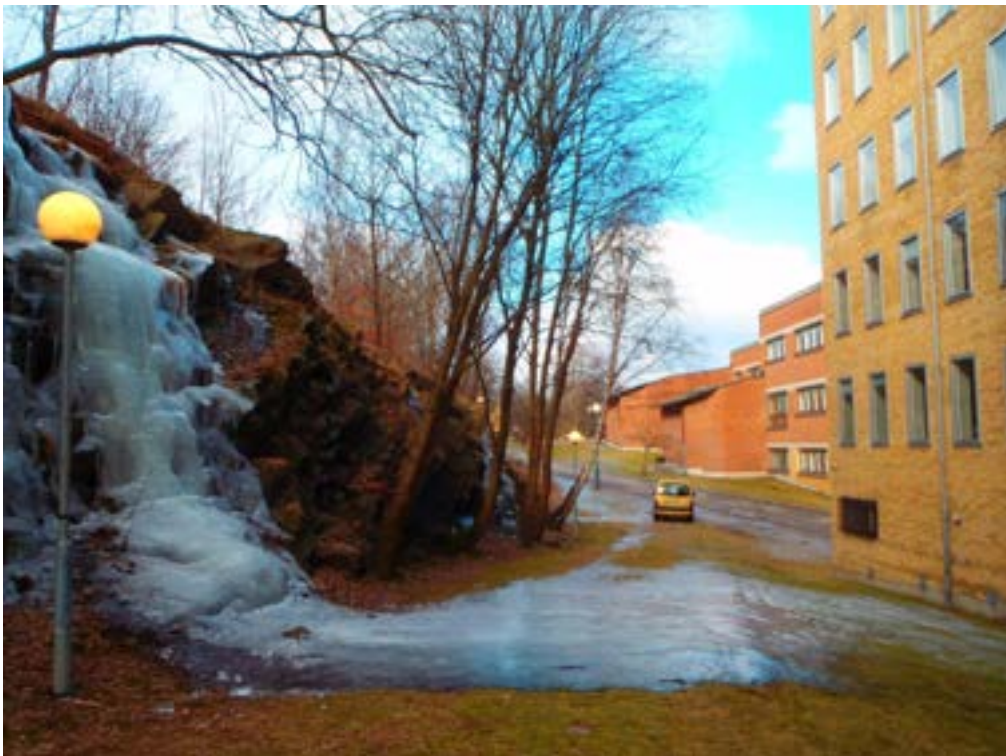
Foto 6. I norra delen av skärningen strömmar vatten ut över släntkrön, fram till byggnaden. Utströmmande vatten och is finns även i den södra delen av skärningen (se Foto 2). Bild tagen mot nordväst.
