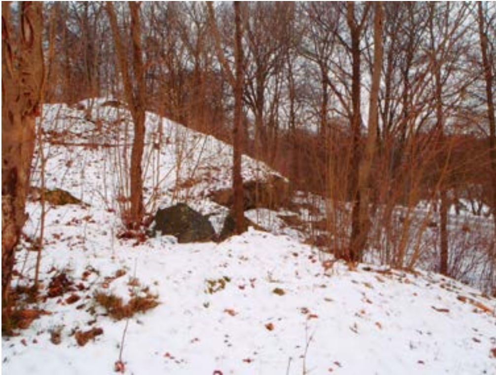
Foto 5. Norra delen av eventuell bergschakt. Skivighetszonen i Foto 5 finns i bergytan mitt i bilden. Slänten bedöms vara stabil idag. Bild tagen mot väst.
