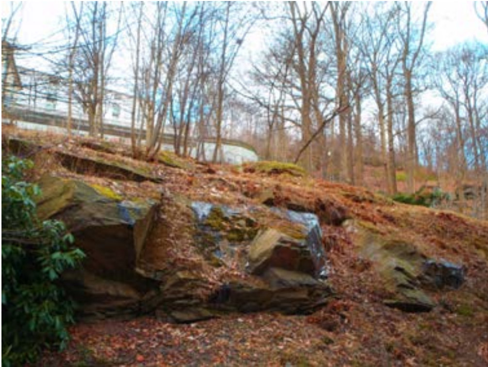
Foto 13. I skärningen sydväst om Eklandagatan 23 finns potentiellt instabila block. Bergrensning bör utföras. Bild tagen upp mot eventuell nybyggnad.
