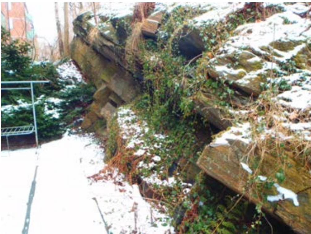
Foto 10. Bakom Eklandagatan 29-31 finns en bergskärning med skivig uppsprickning parallell med gnejsens foliationsriktning. Potentiellt lösa överhäng har bildats. Bilden tagen mot syd, från trappan som leder ned från uteplatsen.
