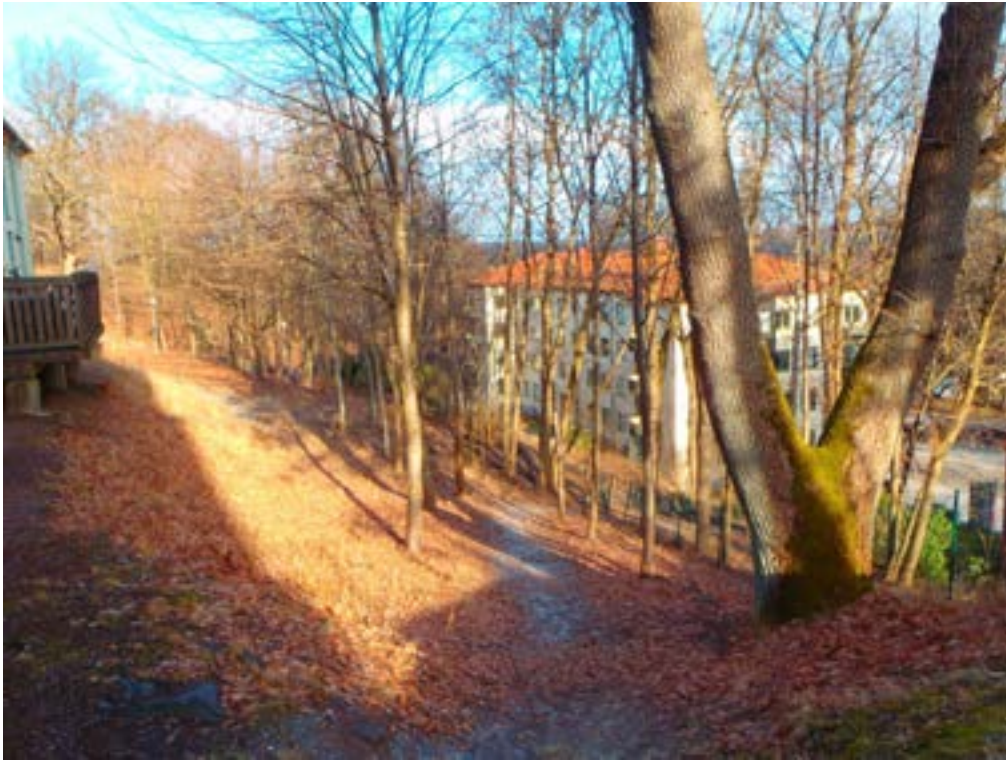
Foto 7. Slänten ned mot Eklandagatan, sedd från pumphusets sydöstra hörn. Slänten består huvudsakligen av jord och block.
