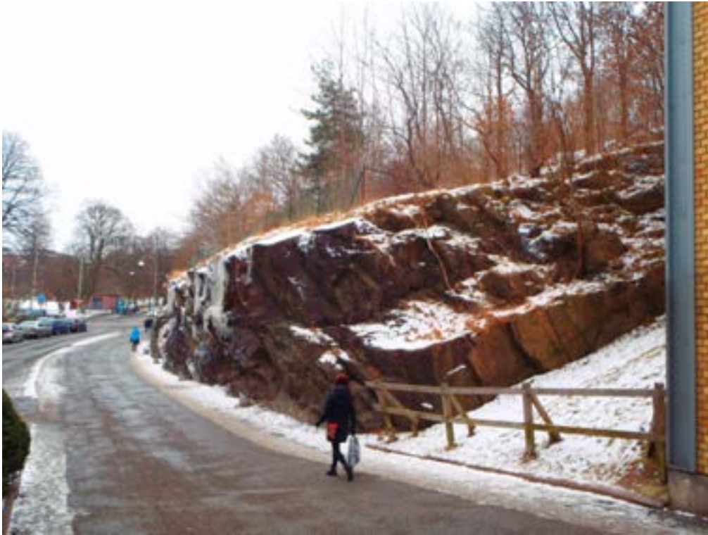
Foto 3. Bergskärningens norra hörn, vid Språkskrapan. Bild tagen mot syd.
