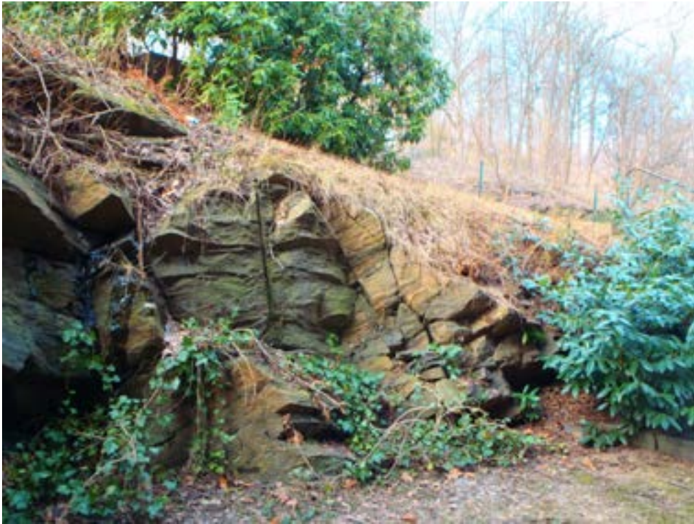
Foto 11. I skärningen bakom Eklandagatan 29-31 finns även sprickplan som kan medföra utglidning. Skärningen bör rensas på löst bergmaterial.
