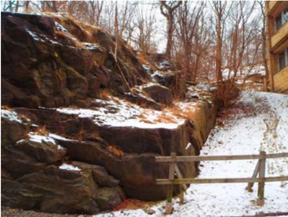
Foto 1. Bergskärningen söder om Språkskrapan bedöms idag vara stabil. Tomtgränsen mot eventuell nybyggnation vid Carlandersplatsen löper uppe på släntkrönet högst upp till vänster i bild. Bild tagen mot sydväst.
