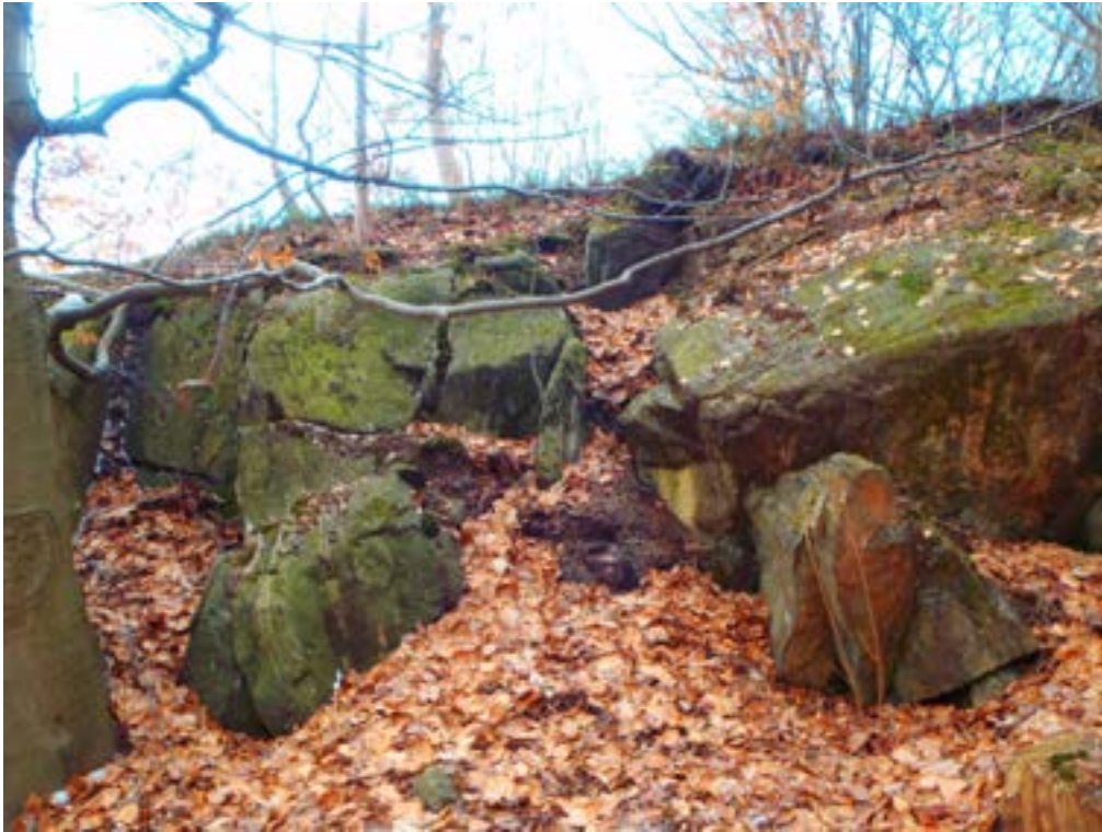
Foto 9. I slänten i Foto 9 noterades s.k. injekteionsmigmatiter, med delvis vittrade mörka bergarter och öppna sprickor (som löper inåt i bilden). Bildens läge är ungefär vid släntfot för en eventuell ny byggnads bakre schaktvägg. Sprickorna löper parallellt med den bakre schaktväggen. Bild tagen mot sydöst.
