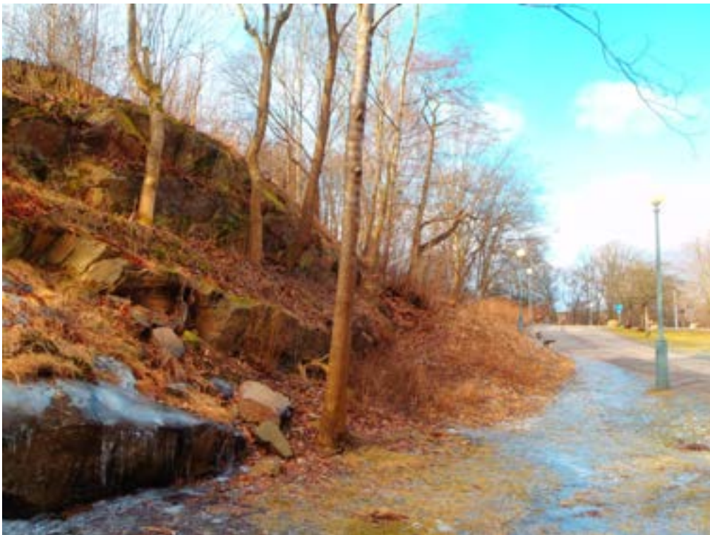
Foto 8. Södra delen av eventuell bergschakt. Södra schaktväggen löper upp i slänten bakom det närmsta trädet. Slänten bortåt i bild bedöms idag vara stabil; hitom det närmsta trädet finns dock löst bergmaterial. Bergrensning bör utföras, se Delområde 3. Bild tagen mot nordväst.
