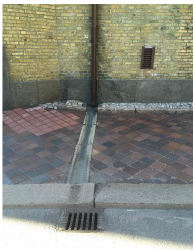
Figur 6. T.v. Avledning via stuprör, ränna och rännstensbrunn till ledningsnät vid Artisten.
