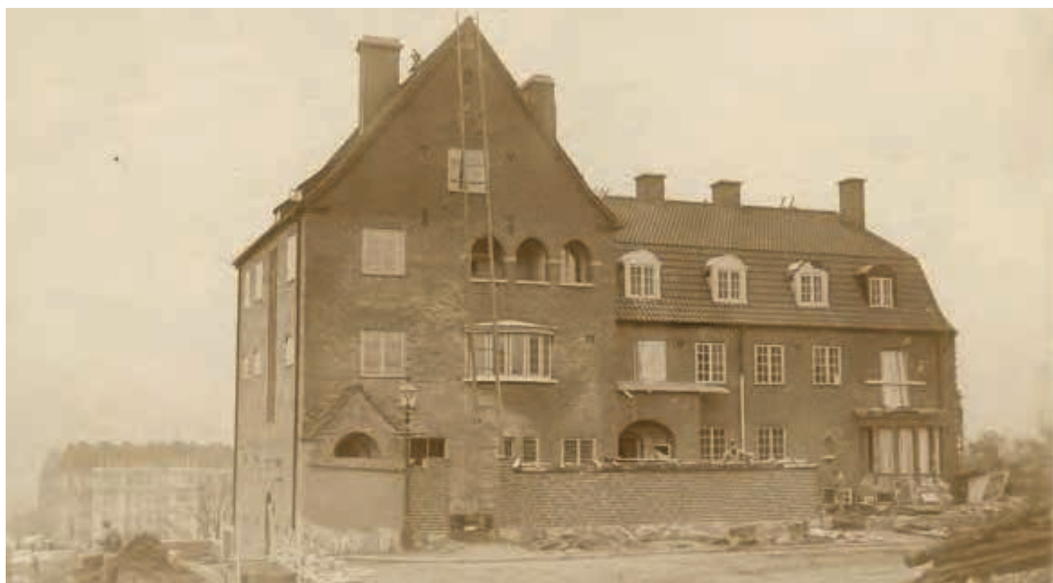
Figur.24: Foto under uppförandet av radhuset på Dicksonsgatan. Foto: Göteborgs stadsmuseum.
