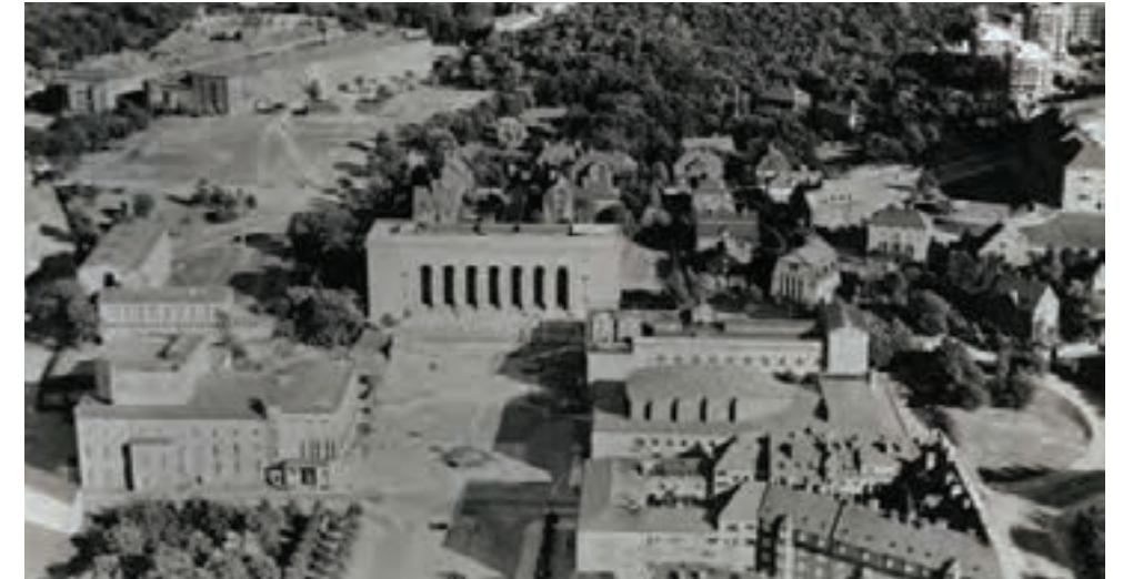
Figur.10:Flygfoto på den färdigställda Götaplatsen taget någon gång mellan 1935 och 1948. Foto Göteborgs stadsmuseum.
