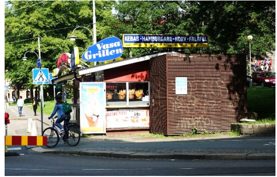
Kiosk och teknikbyggnad från sydväst.
