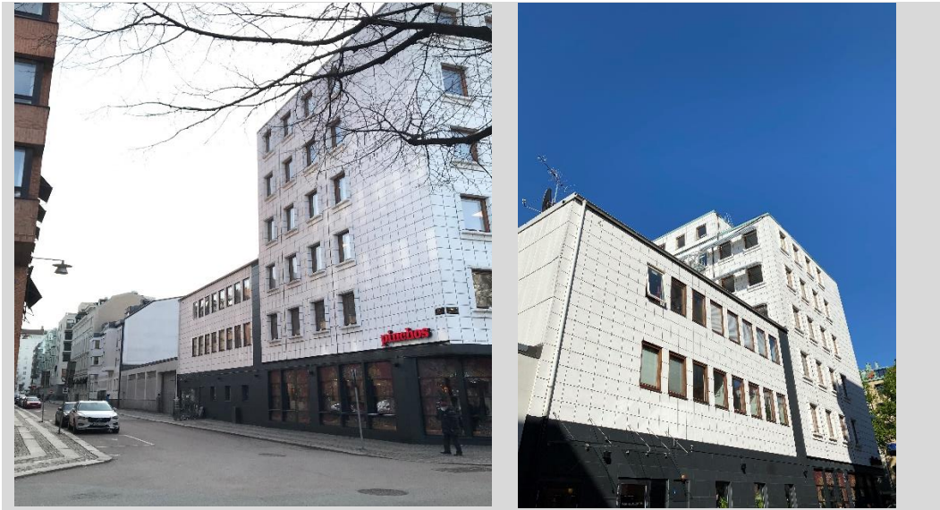
Foto på befintlig byggnad inom Lorensberg 53:2.
