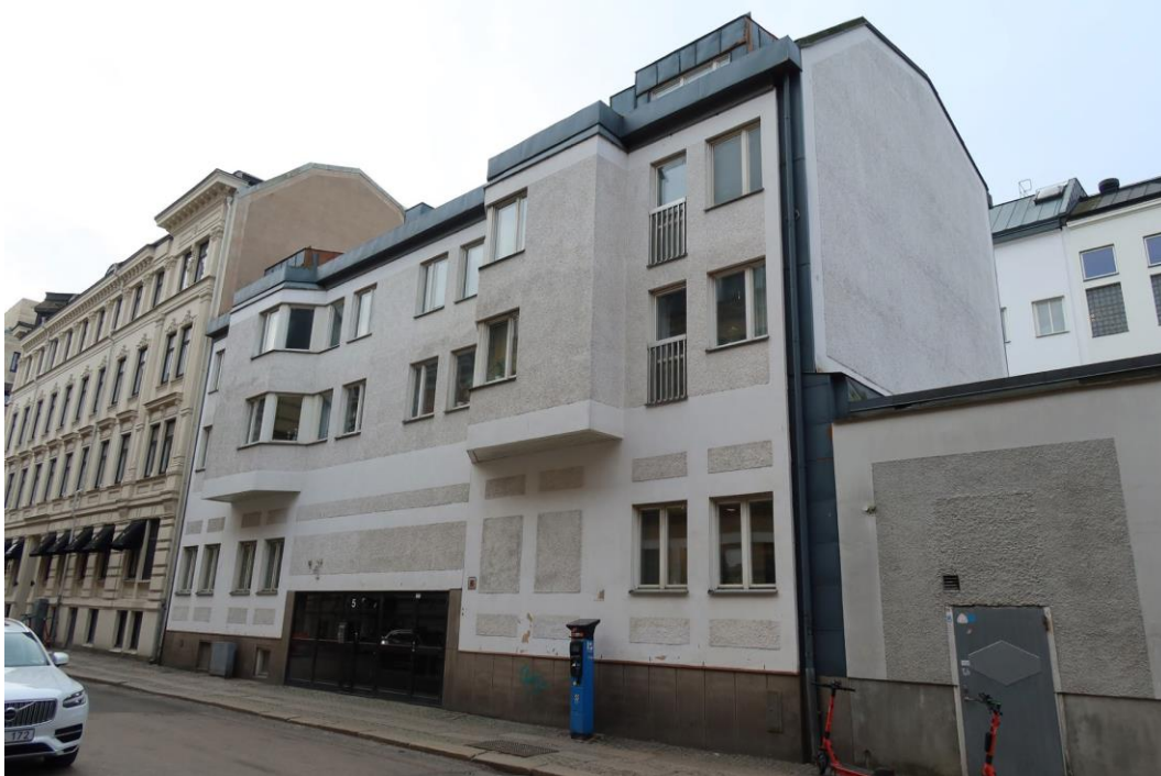
Foto på befintlig bostadsbebyggelse inom Lorenberg 53:4, Lorenbergsgatan 5
