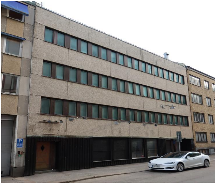
Foto på befintlig byggnad inom Lorensberg 55:8.
