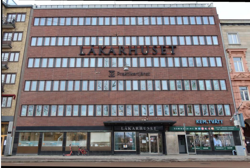
Foto på befintlig byggnad inom Lorensberg 55:4.
