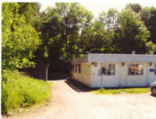
Befintlig förskola är en enkel byggnad.
