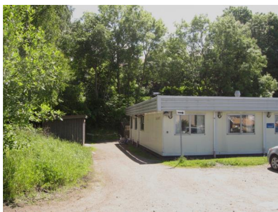
Befintlig förskola är en enkel byggnad.
