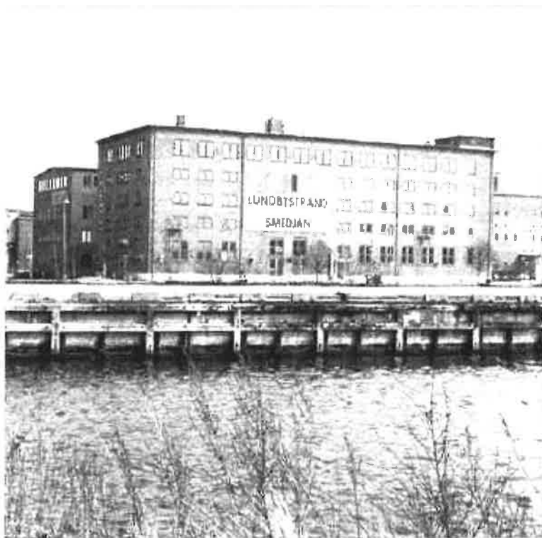
Smedjan uppfördes 1946 (bild ur bevarandeprogrammet)
