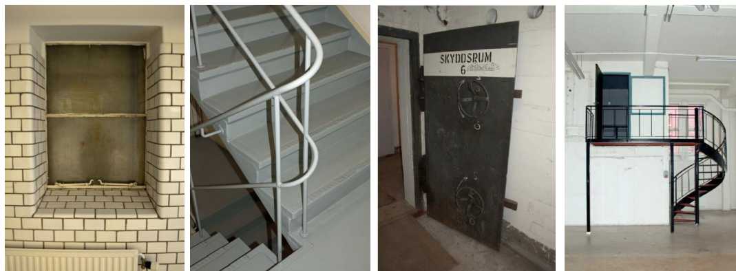
Interiöra detaljer ur: Smedjan: Götaverken - kulturmiljöunderlag, Stadsbyggnadskontoret, mars 2016.
