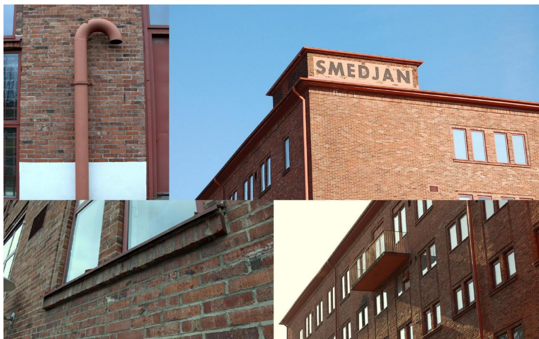
Exteriöra detaljer ur: Smedjan: Götaverken - kulturmiljöunderlag, Stadsbyggnadskontoret, mars 2016.
