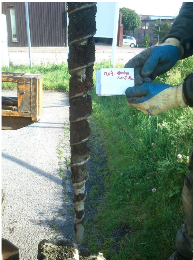
Figur 4.1. Skruvborrning i Skr 1204 (djup 1,0 - 2,0 m) med slaggrester i fyllnadsmaterialet.
