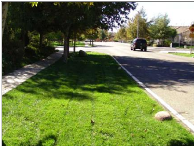
Figur 8 Exempel på dike för dagvattenhantering.
