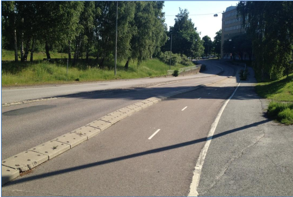
Figur 15 Lågpunkt i Karlavagnsgatan utgör skyfallsmagasin.
