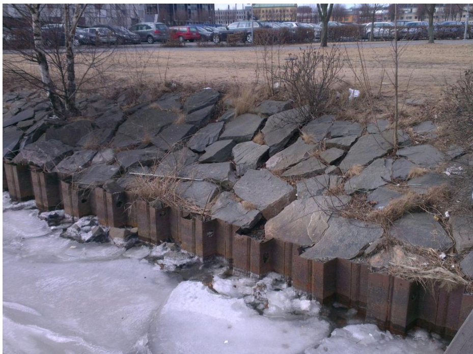
Bild 2.3 Befintlig spont samt erosionsskydd vid hamnbassängen i söder, vy från sydost mot nordväst.
