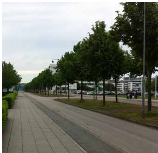
Befintliga ytor med betongsten, asfalt och kantsten i granit utmed Götaverksgatan
