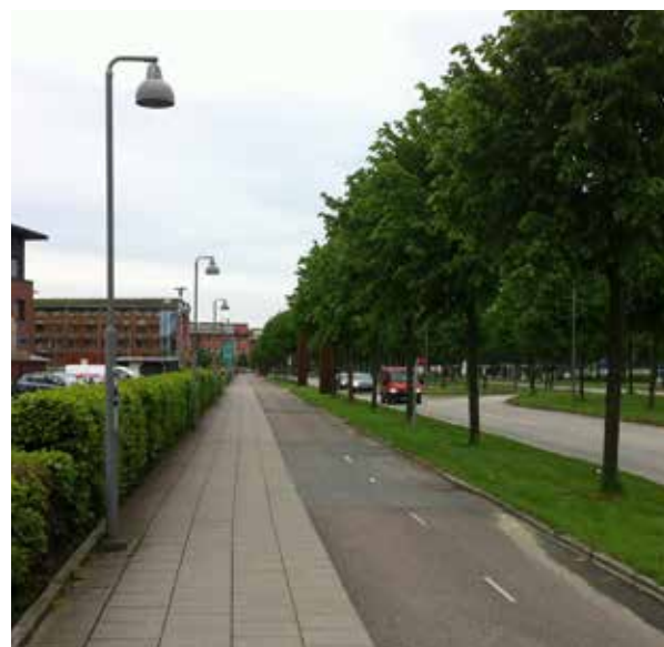
Befintliga ytor med betongsten, asfalt och kantsten i granit utmed Götaverksgatan samt lägre belysningsarmatur utmed gång- och cykelbanan
