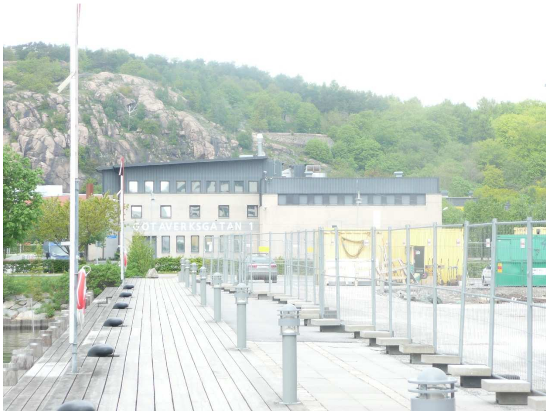
Restaurang inryms i Götaverksgatan 1, huset kommer att rivas. Bild Kvarnström Arkitektkontor.
