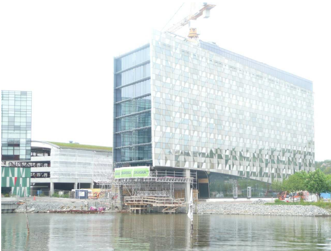
Hotellet väster om planområdet som är under uppförande. Bild Kvarnström Arkitektkontor.
