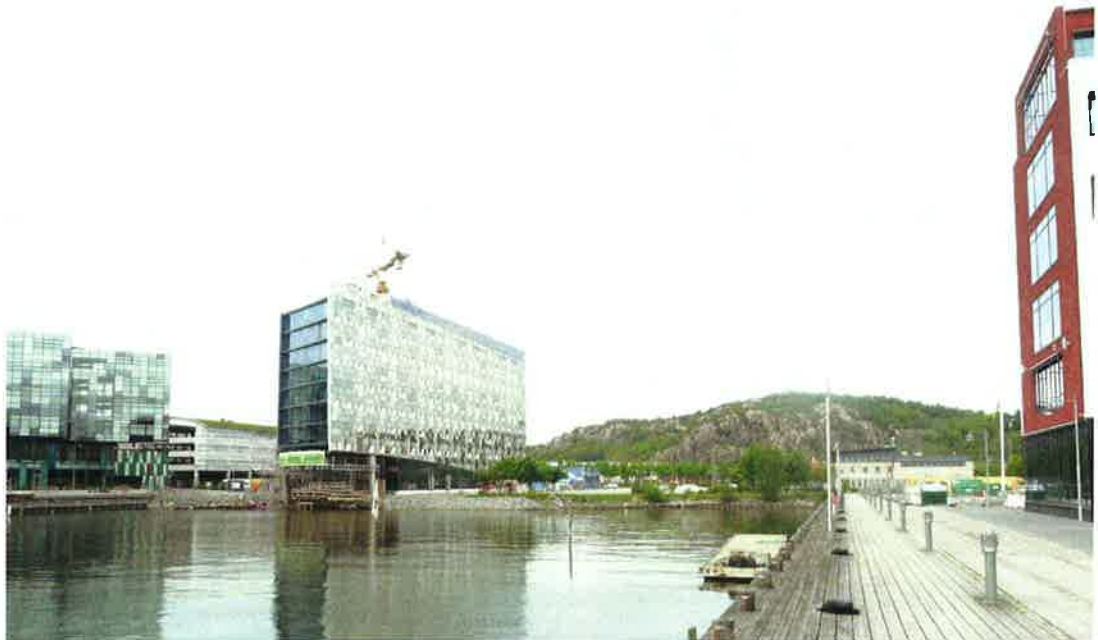
Vy över planområdets sydvästra del med Lindholmsbassängen i förgrunden och Ramberget i bakgrunden. Bild: Kvarnström Arkitektkontor.
