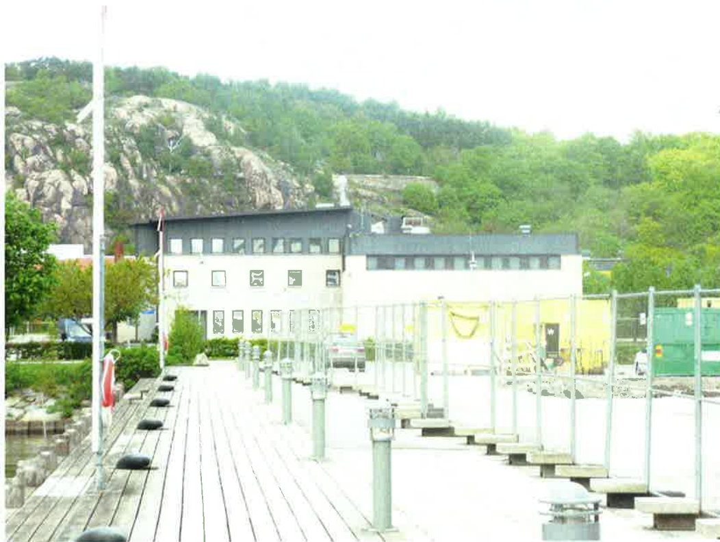
Restaurang inryms i Götaverksg. 1, huset kommer att rivas. Bild: Kvarnström Arkitektkontor.
