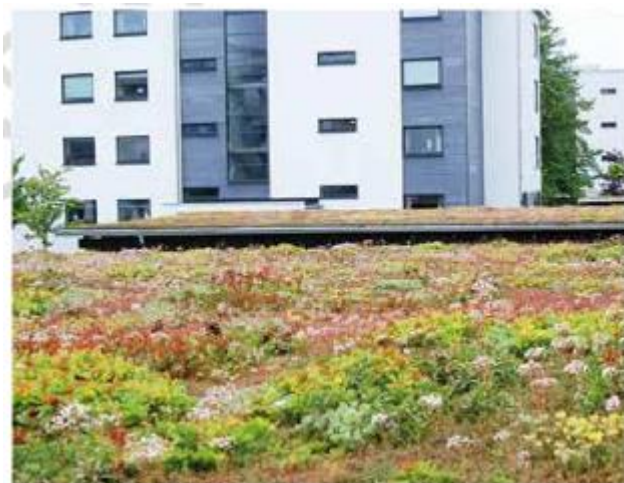
Figur 16. Hus med grönt tak. Foto: Veg Tech
