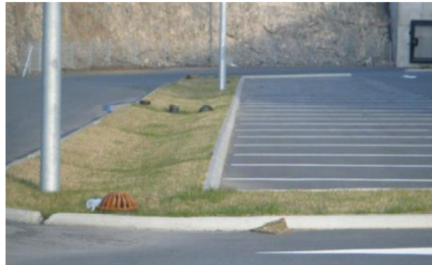
Figur 11. Svackdiken. Till höger svackdike med stensatt kant och kupolbrunn
