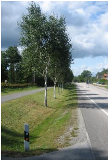
Figur 11. Svackdiken. Till höger svackdike med stensatt kant och kupolbrunn
