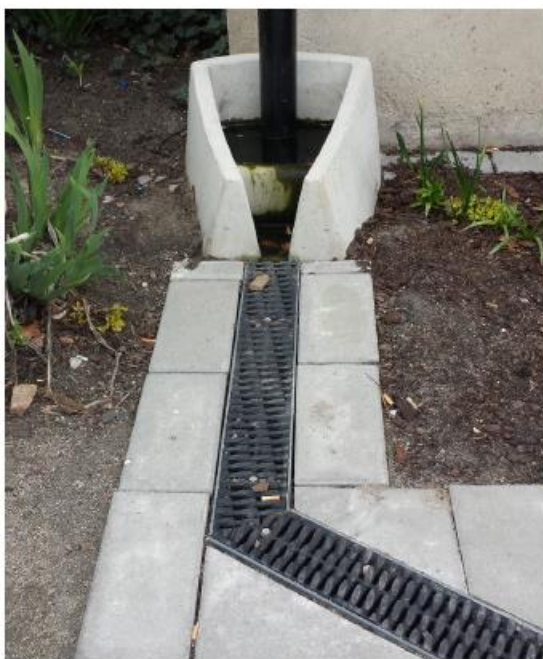
Figur 10. Exempel på täckt och öppen ränna.
