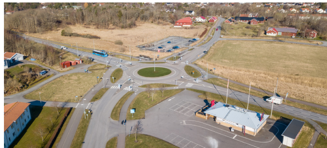
Lillebygrillen och rondellen i Kongahällavägen snett ovanifrån.
