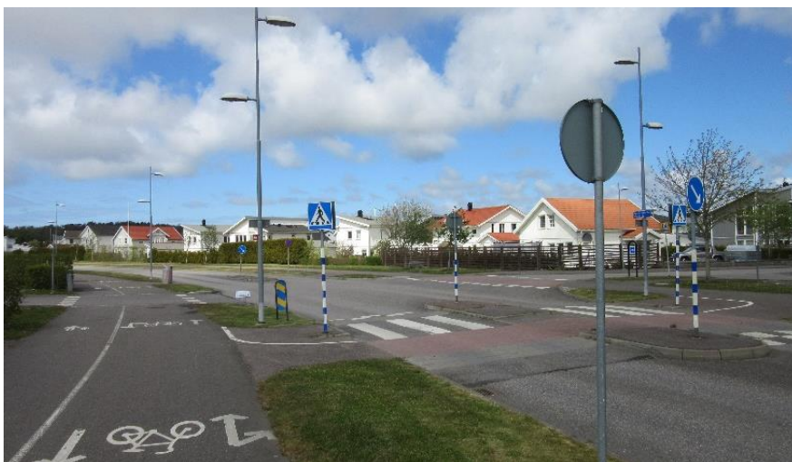
C.3:8 Nya Älvegårdsvägen, exempel på hastighetssäkrad passage.
