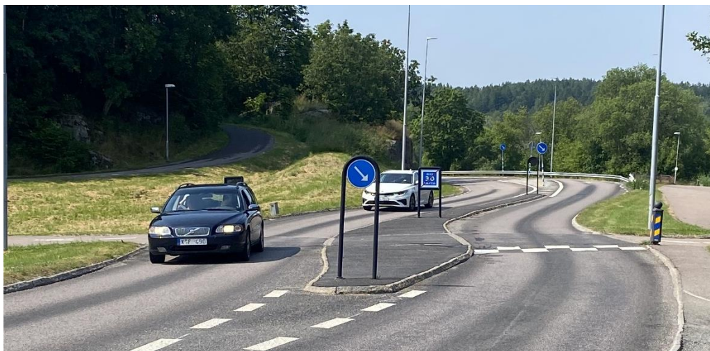
E.1:24 Exempel på utformning av hastighetsdämpande ”port”.
