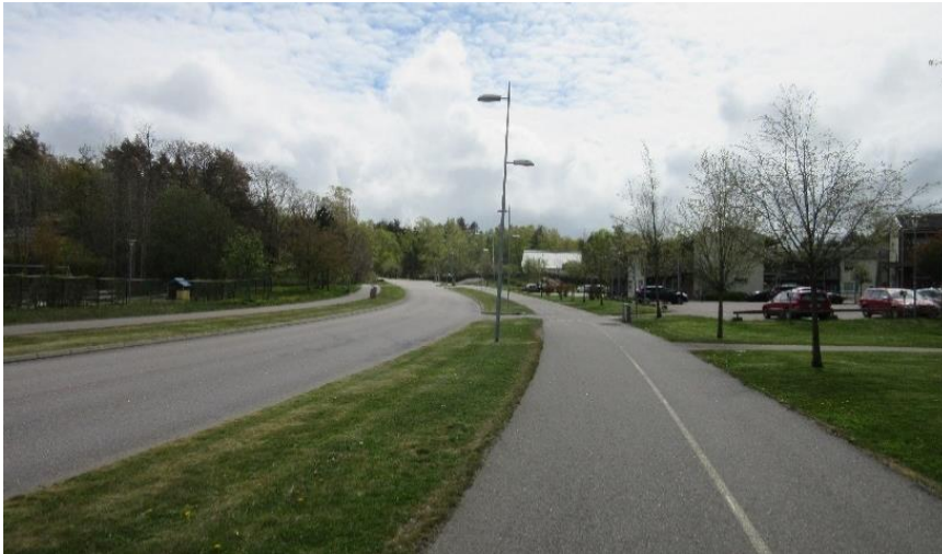
C.3:7 Nya Älvegårdsvägen i Älvegårdsområdet.
