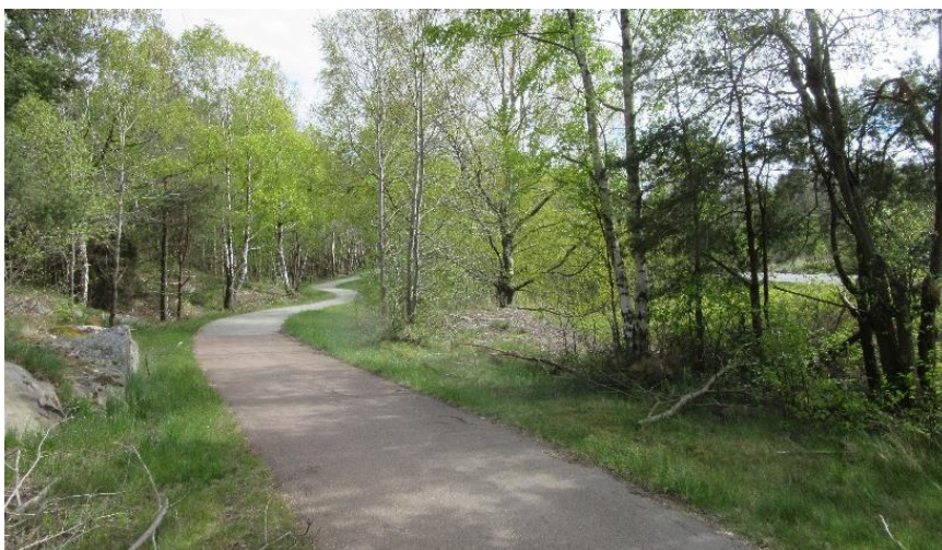
C.3:5 Bulyckevägen, friliggande gång- och cykelväg
