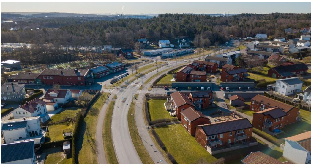
C.1:4 Bilder över Älvegårdsområdet mot söder med Nya Älvegårdsvägen (foto: Oliver Willskytt)
