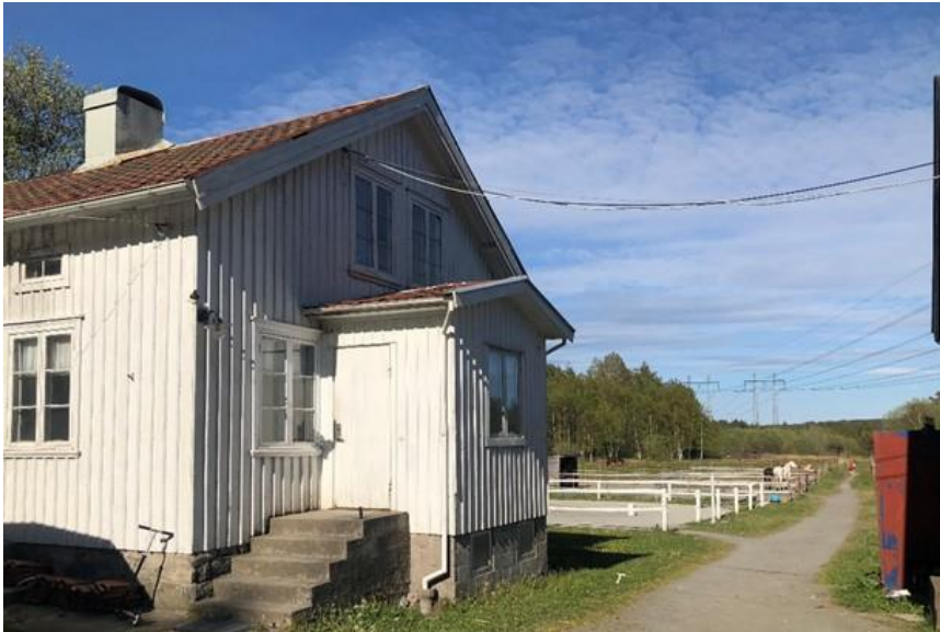
F.2:2 Den äldre gårdsbebyggelsen med tillhörande hagmarker bidrar till områdets upplevelsevärde. Vägutbyggnaden kommer att påverka upplevelsen av områdets karaktär där gården och angränsande bebyggelse utgör en central roll.
