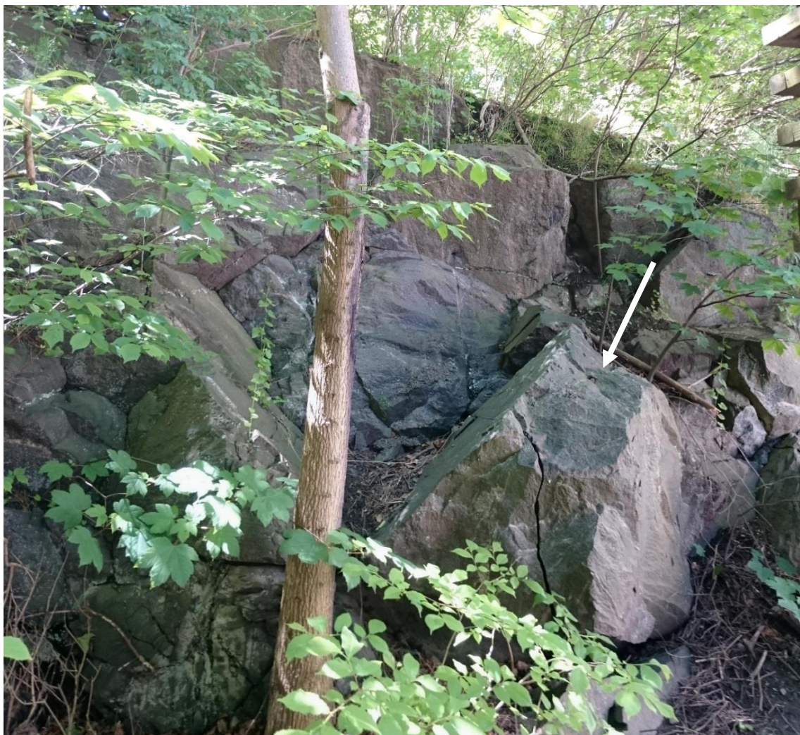
Bild 4. Östra bergskärningen från innergården. Block har fallit ut, se pilmarkering.
