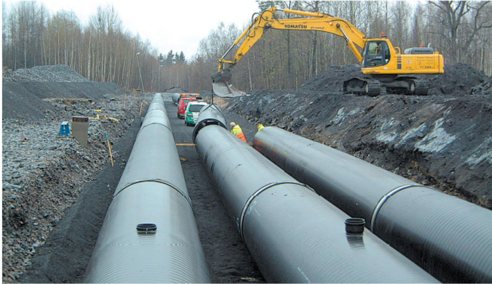
Figur 8. Dagvattenmagasin av Weholite dubbelväggiga lättviktsrör, polyeten.
