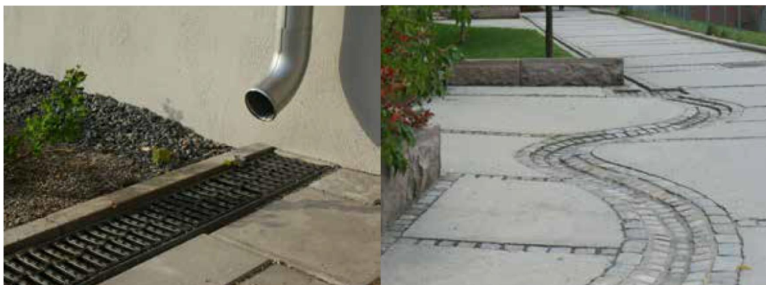
Figur 1 och 2. Exempel på utformning av stuprörsutkastare tillsammans med dagvattenränna och rännald med gatsten.
