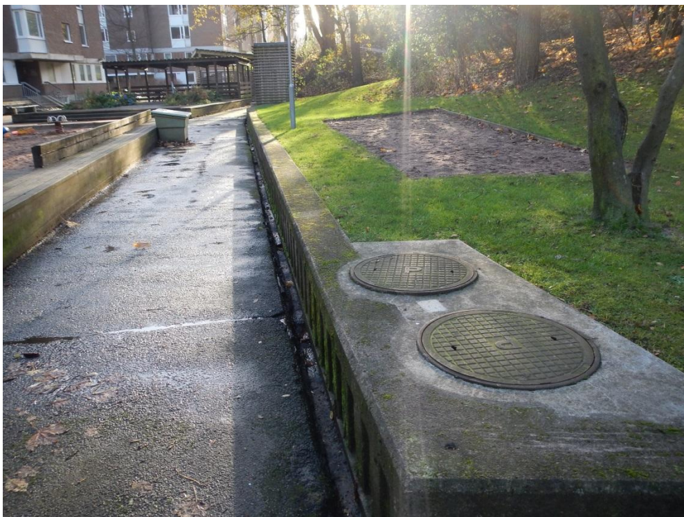
Figur 4. Bild från innergården som visar befintliga brunnar och dagvattenränna mot den upphöjda muren och grönområdet. Bilden är tagen från innergården i riktning söderut. Även innergårdens lekplats och en plantering kan ses i vänsterkanten.
