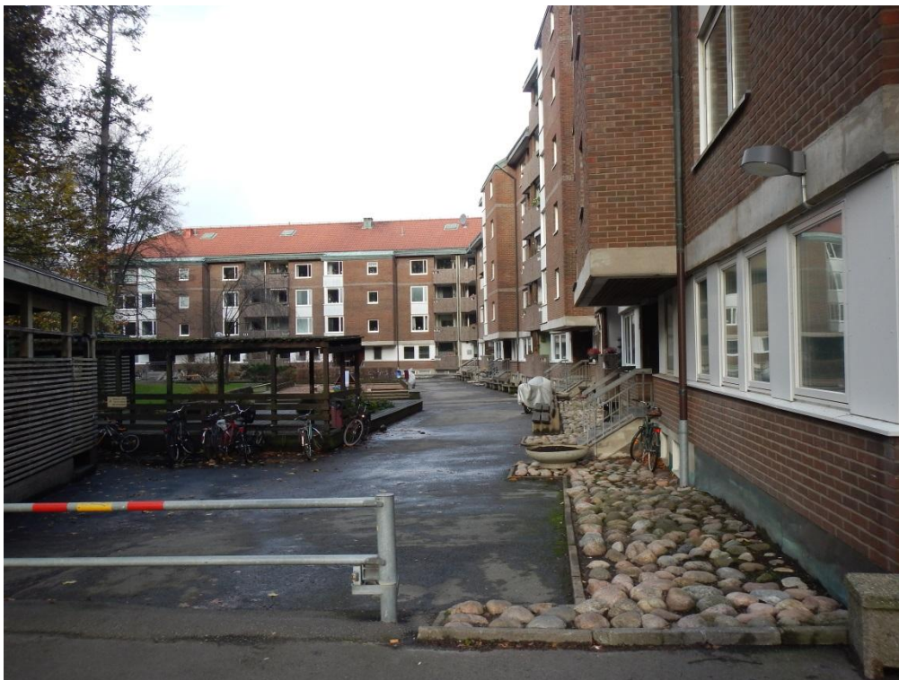
Figur 2. Befintligt bostadshus samt innergården. Bilden tagen från planområdets sydvästra del i riktning norrut. I vänsterkanten kan befintligt avfallshus ses.
