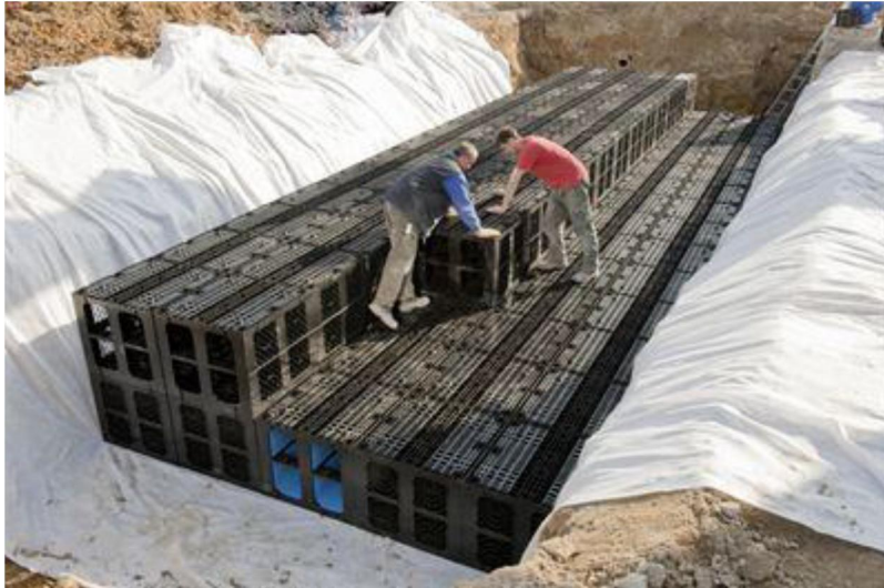
Figur 12. Visar montering av kassetter för dagvattenhantering med geotextil. Källa: www.rehau.com
