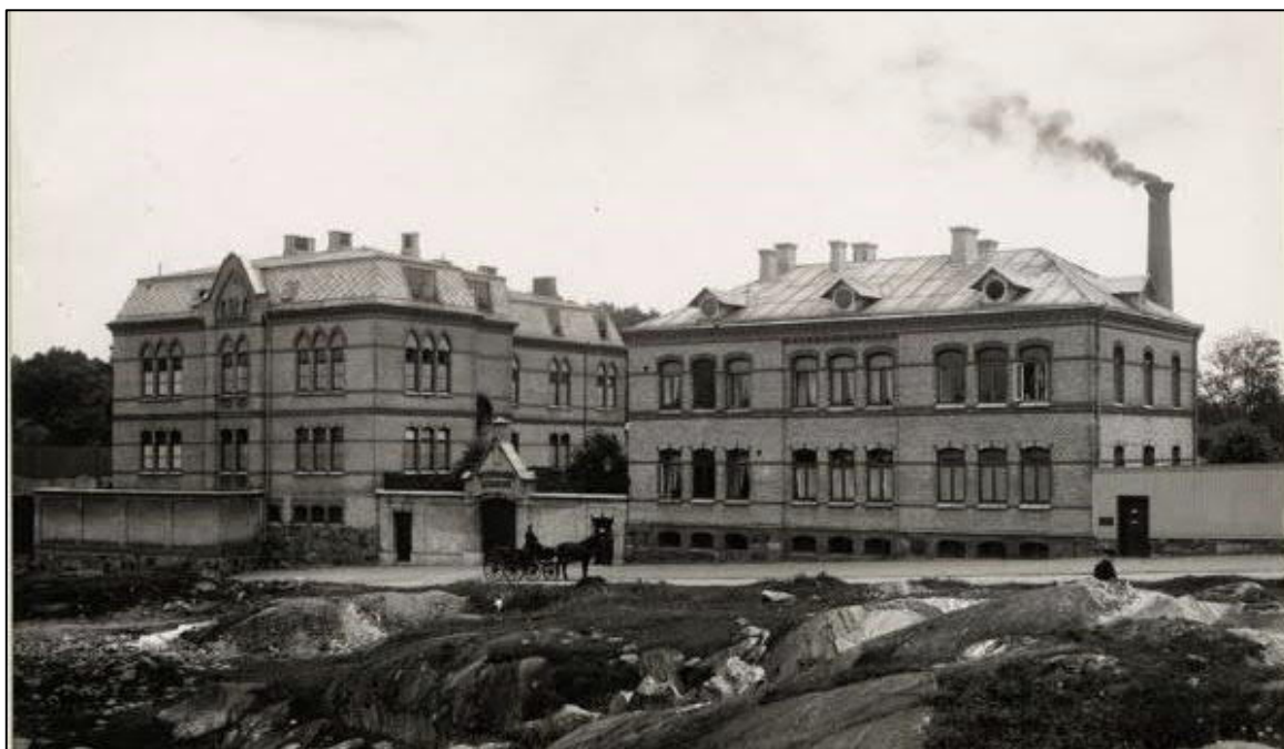
Figur 5 Holtermanska sjukhuset sett från norr. Till höger och främst i bilden syns administrationsbyggnaden och bakom den ekonomibygnaden med den höga skorstenen. Bild från hemsidan https://goteborgshistoria.com/2017/08/04/helsotillstandet-i-goteborg-2/
