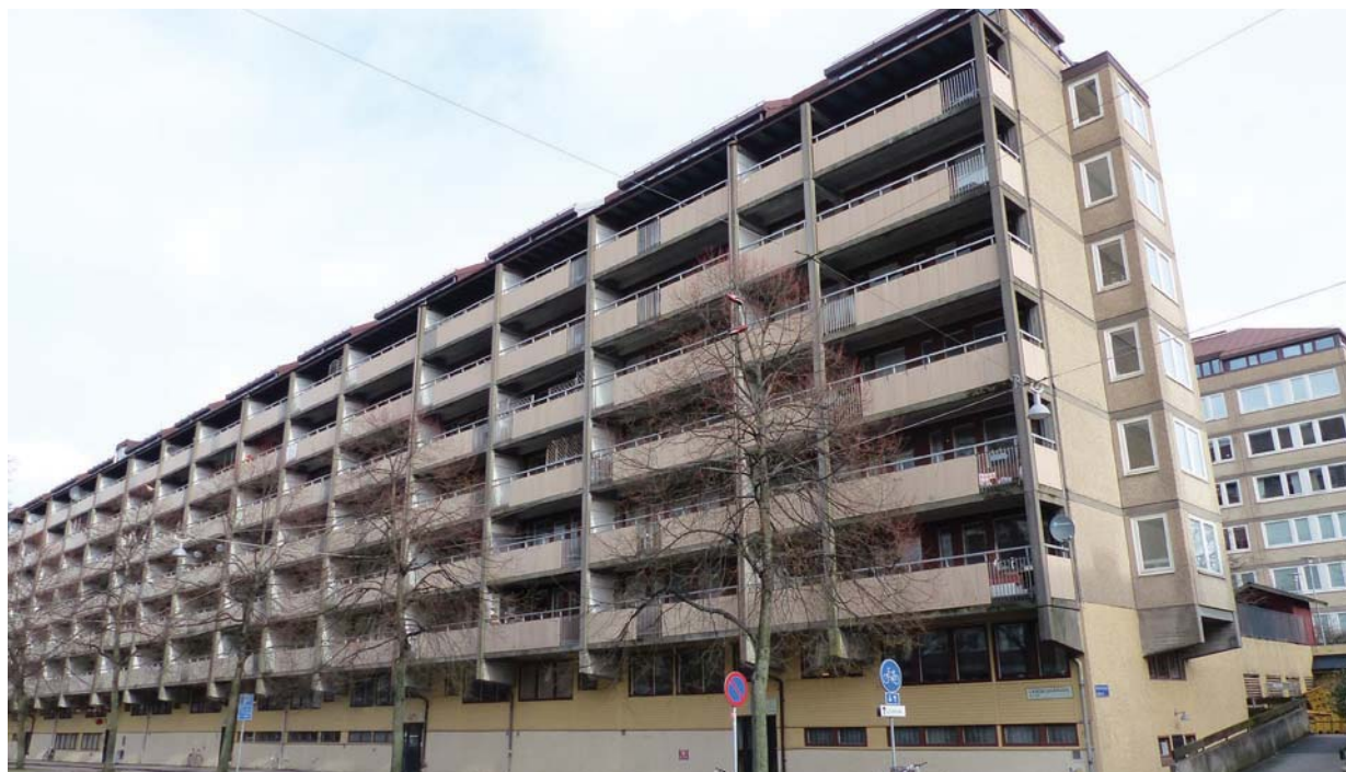
Lars Ågrens korridorhus tar den prefabricerade storskaligheten till en ny nivå i Landala. De utsträckta fasaderna rytmiseras av balkongernas linjering och betongelementens skarvar men uppvisar likväl ett monotont uttryck.
