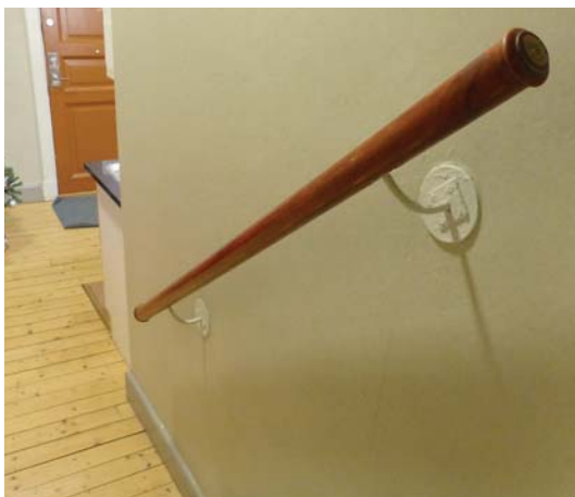
Ursprungliga detaljer i form av spegeldörrar av olika typ och storlek, mönstrad cementklinker, trappsteg i lågerhuggen kalksten, ledstång i tår med smideskonsoller samt en takrosett från våning 2.
