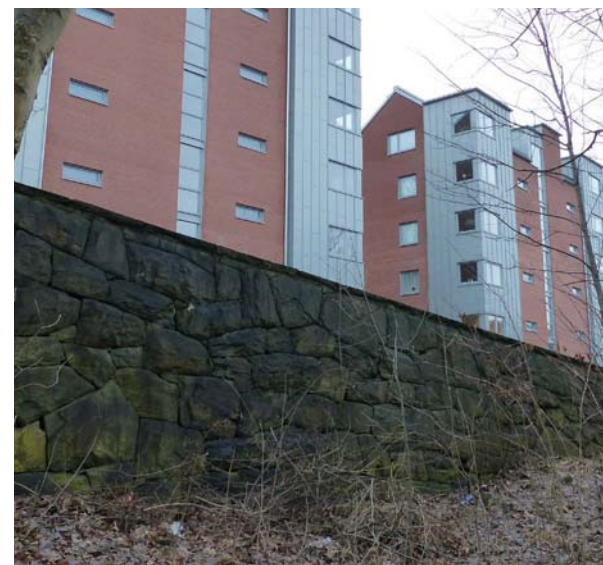
Del av den i detaljplan skyddade terrassmuren vid Egnahemsvägen.
