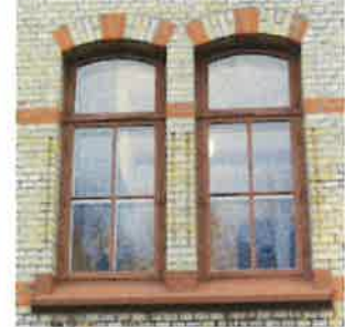
Detaljer med plåttak med takfönster, mönstermurat tegel i gult och rött samt ursprunglig fönsterindelning av två olika typer.
