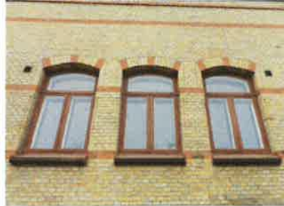
Detaljer med plåttak med takfönster, mönstermurat tegel i gult och rött samt ursprunglig fönsterindelning av två olika typer.
