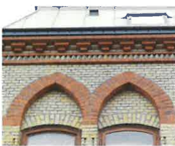
Detaljer med plåttak med takfönster, mönstermurat tegel i gult och rött samt ursprunglig fönsterindelning av två olika typer.
