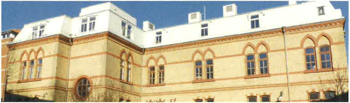
Hus B, manliga paviljongen, med brant tak takfall med takkupor, stickbågiga fönster och det runda trapphusfönstret sett från gården i sydväst.
