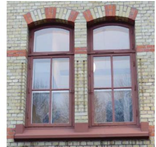
Detaljer med plåttak med takfönster, mönstermurat tegel i gult och rött samt ursprungliga fönster av två olika typer.
