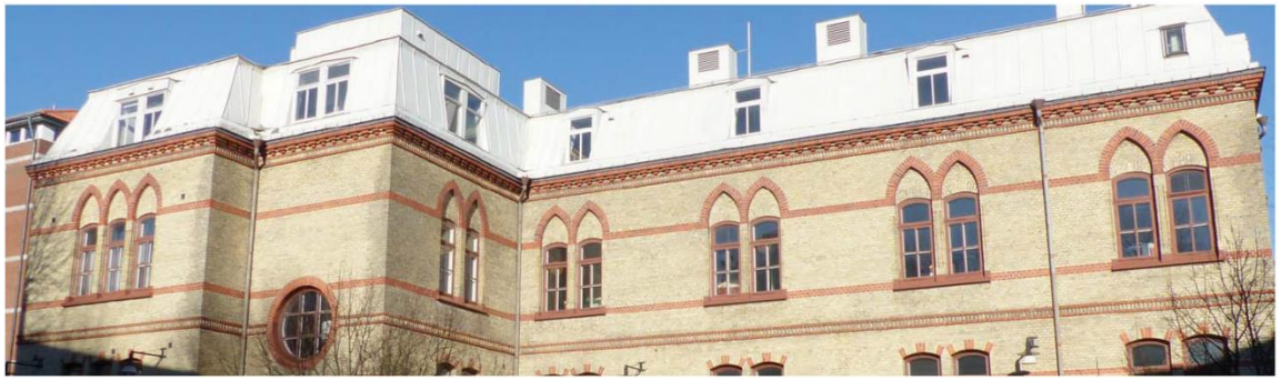
Hus B, manliga paviljongen, med brant tak takfall med takkupor, ursprungliga stickbågiga fönster och det runda trapphusfönstret sett från gården i sydväst.
