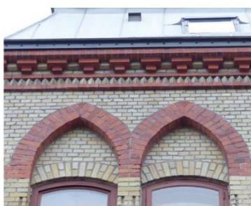
Detaljer med plåttak med takfönster, mönstermurat tegel i gult och rött samt ursprungliga fönster av två olika typer.
