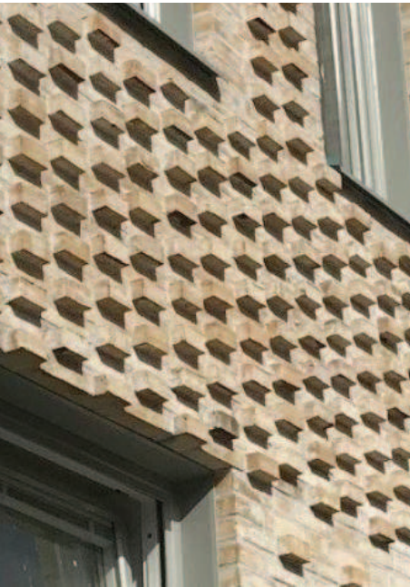
Fasadens utformning avslutas med en subtillt artikulerad krona med mönstermurning som ger skuggspel.
