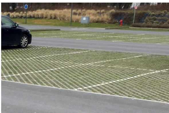
Figur 17 Till vänster ett exempel på gräsarmerad parkeringsyta (VA syd, 2020). Till höger ett exempel på ett svackdike (Göteborgs stad, Ramböll, 2017).
