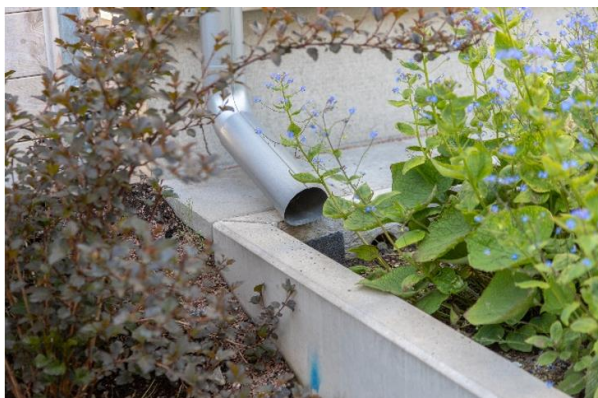
Figur 16 Exempel på regnrabatt/biobädd vid Sunnerviksgatan norr om planområdet. Foto: Lina Ekholm
