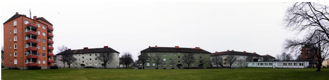
Bebyggelse runt planområdet sedd från norr
