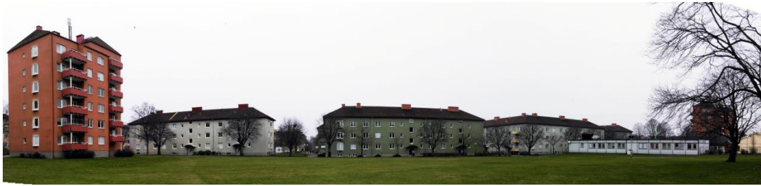
Bebyggelse runt planområdet sedd från norr
