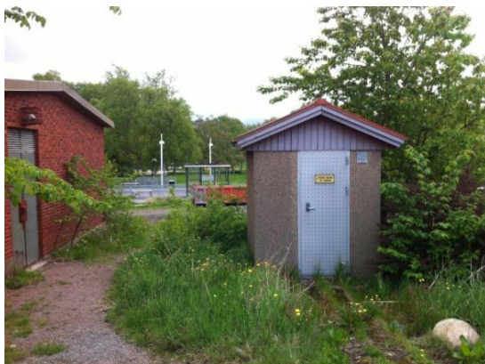
Teknisk anläggning med olja.
