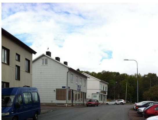
Flerbostadshus längs Södra Vårvindsgatan där bottenvåningen innehåller handelslokaler.
