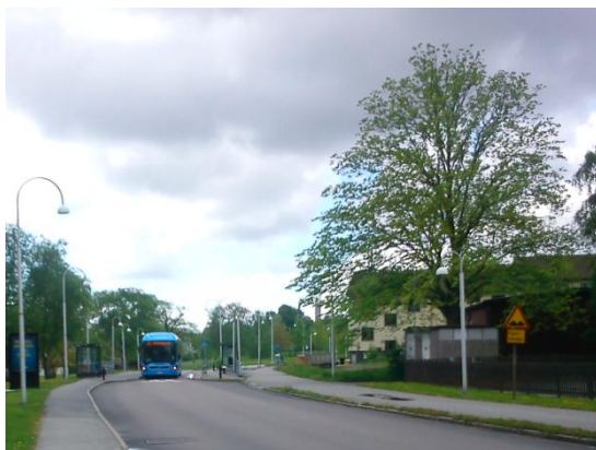
Teknisk anläggning, nätstation
