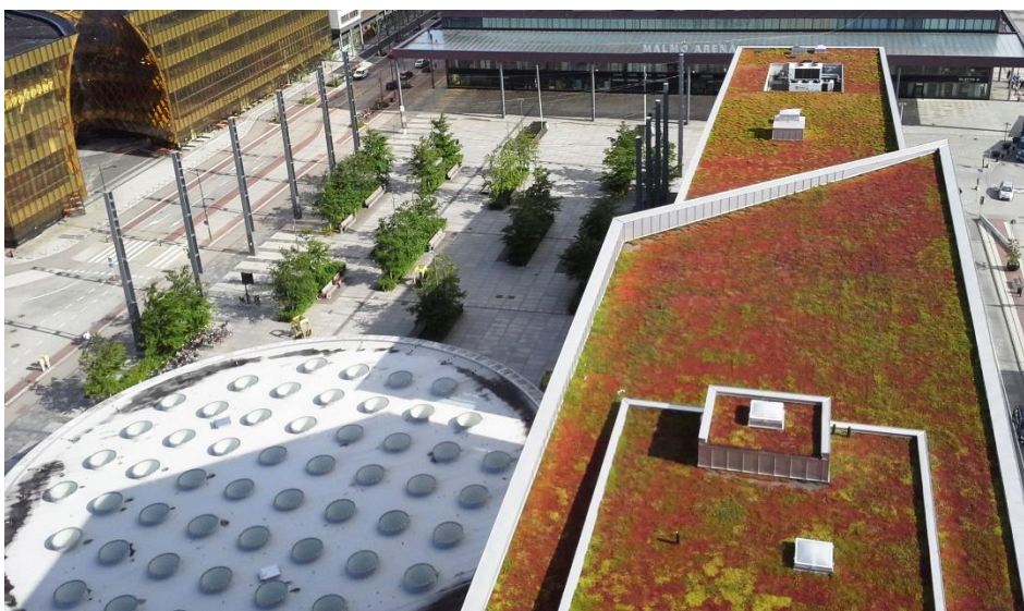
Figur 8 Exempelbild av ett sedumtak. Bild från Veg Tech (Veg Tech, 2020).
