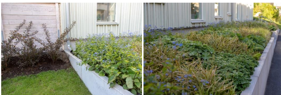
Figur 9 Exempel på regnrabatt intill fasad vid Sunnerviksgatan. Foto: Lina Ekholm.
