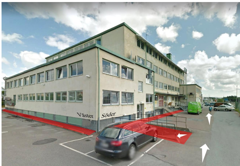
Figur 6 Bild från Google Maps från 2011 över byggnadens västra och södra del (till vänster respektive höger i bild) och markering som visar ungefär att vatten riskerar att ansamlas mot byggnadens södra och västra del vid skyfall. Pilar visar flödesriktning.
