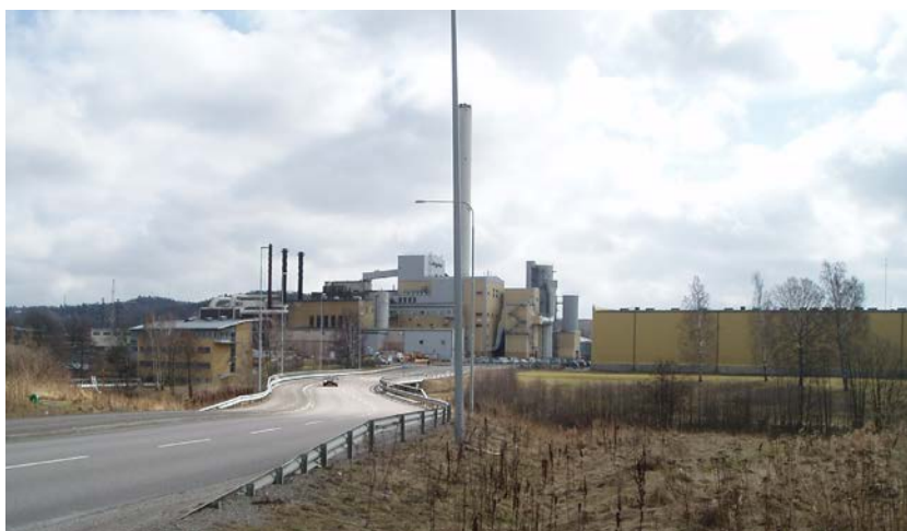
Sävenäs kraftvärmeverk och SKF söder och sydväst om planområdet.
