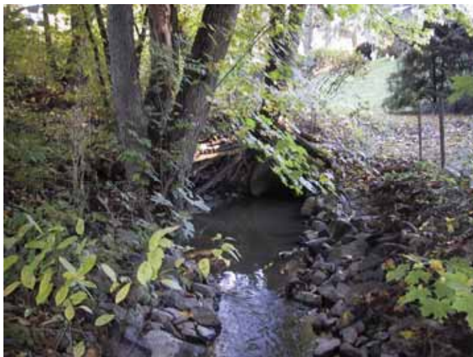
Bilden visar norra delen av avsnitt III, och här skymtar den kulvert som sträcker sig vidare under tomtmark och under Utbyvägen.
