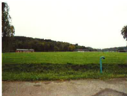
Omklädningsbyggnad samt förrådsbyggnader vid de öppna fälten
