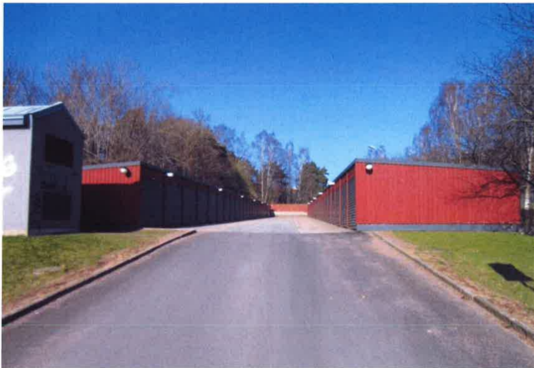
Transformatorstation och radgarage
