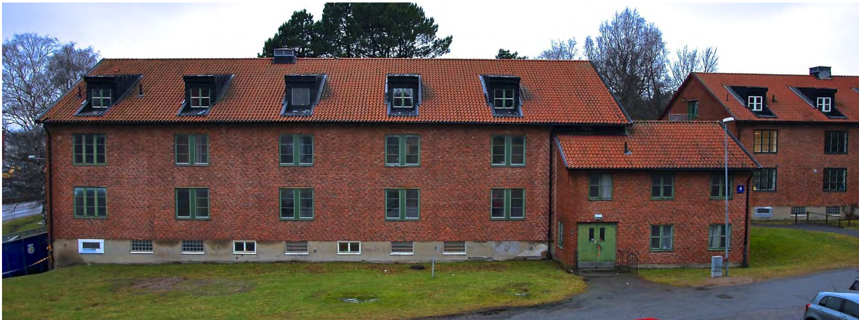
Fasadbild över kasernbyggnad längst i söder.
