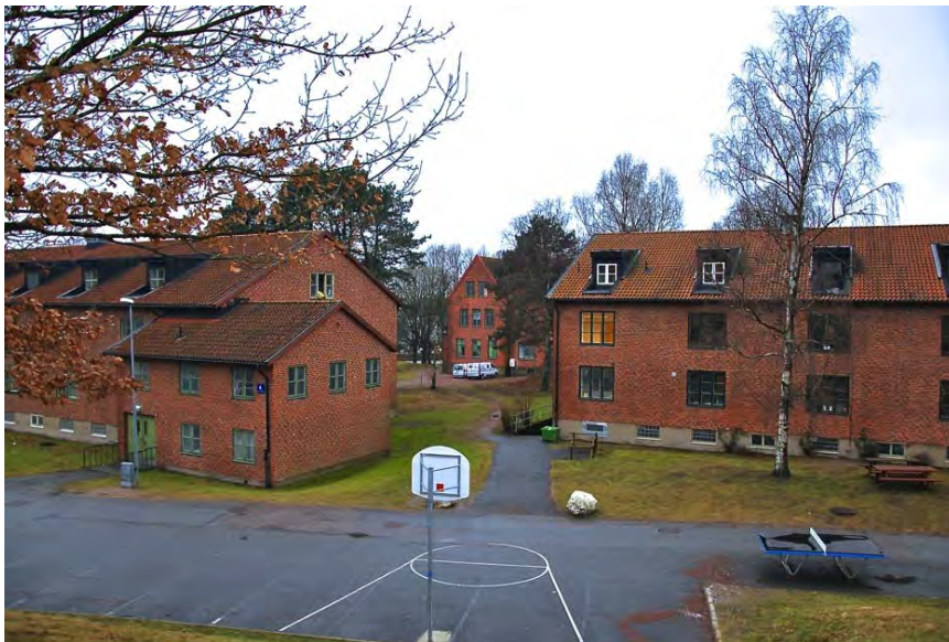
Sjukpaviljongen skymtades mellan kasernbyggnaderna.
