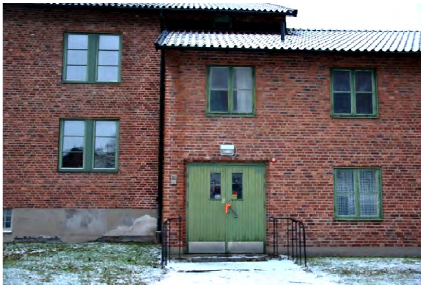
Detalj på mötet med de två byggnadskropparna.
