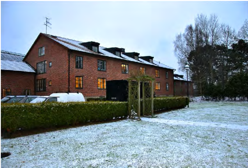
Kasernbyggnad från väster. Närheten till grönskan går att se både som anlagd trädgård men också med naturkaraktär.
