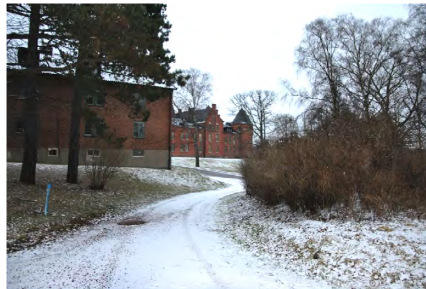
Ett stråk av växtlighet från sjukpaviljongen, en kasernbyggnad och Kvibergs kaserner sett från sjukpaviljongen.
