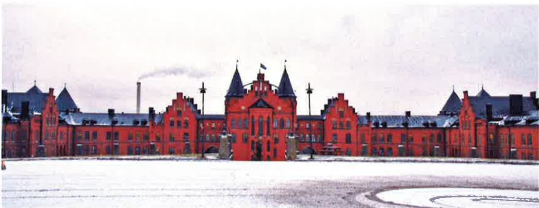
Öster om planområdet ligger byggnadsminnet Kvibergskaserner
