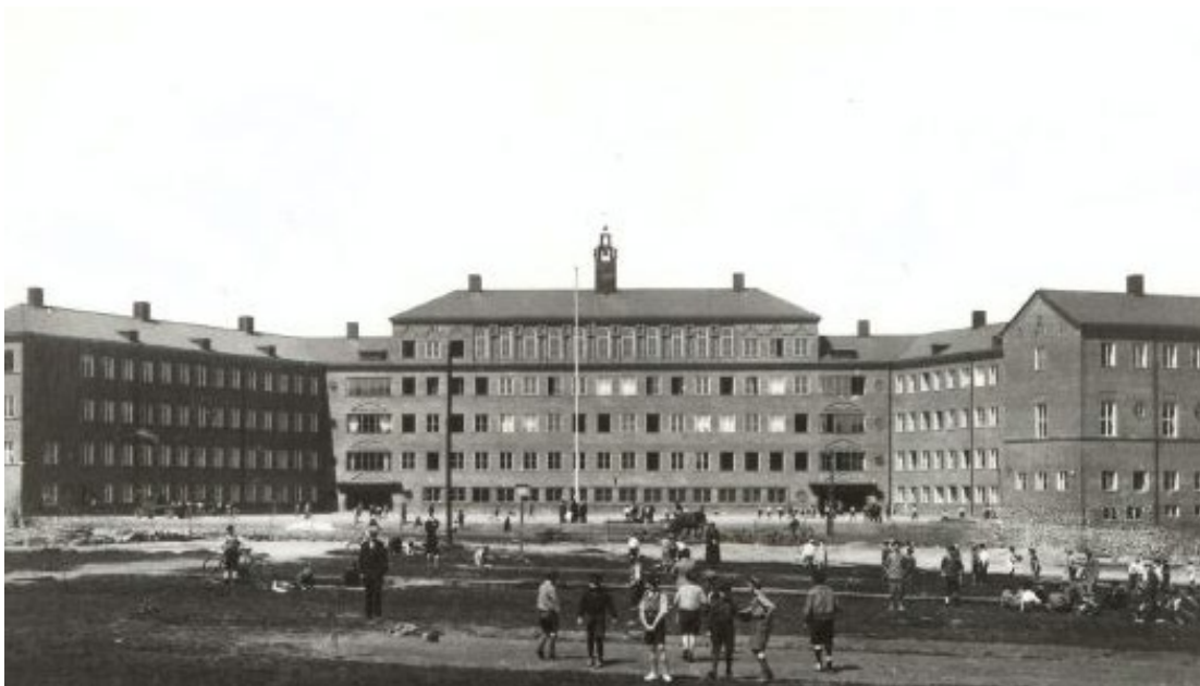
Foto, Kungsladugårdsskolan med uppställning mot gårdssidan, sent 1930-tal, GSM.
