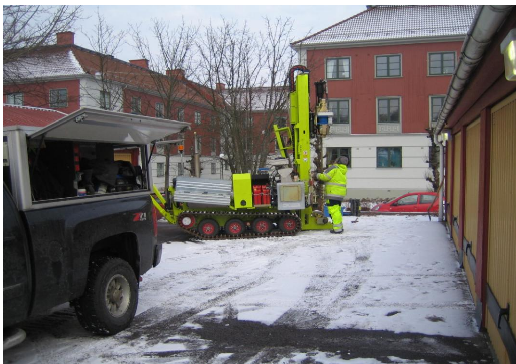
BH2 med garagelängor på vardera sidan och lokalgata och bostadshus i bakgrunden.
