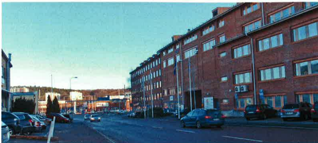
Vy från väster över Varbergsgatan i förlängningen ligger Varbergsbro.
