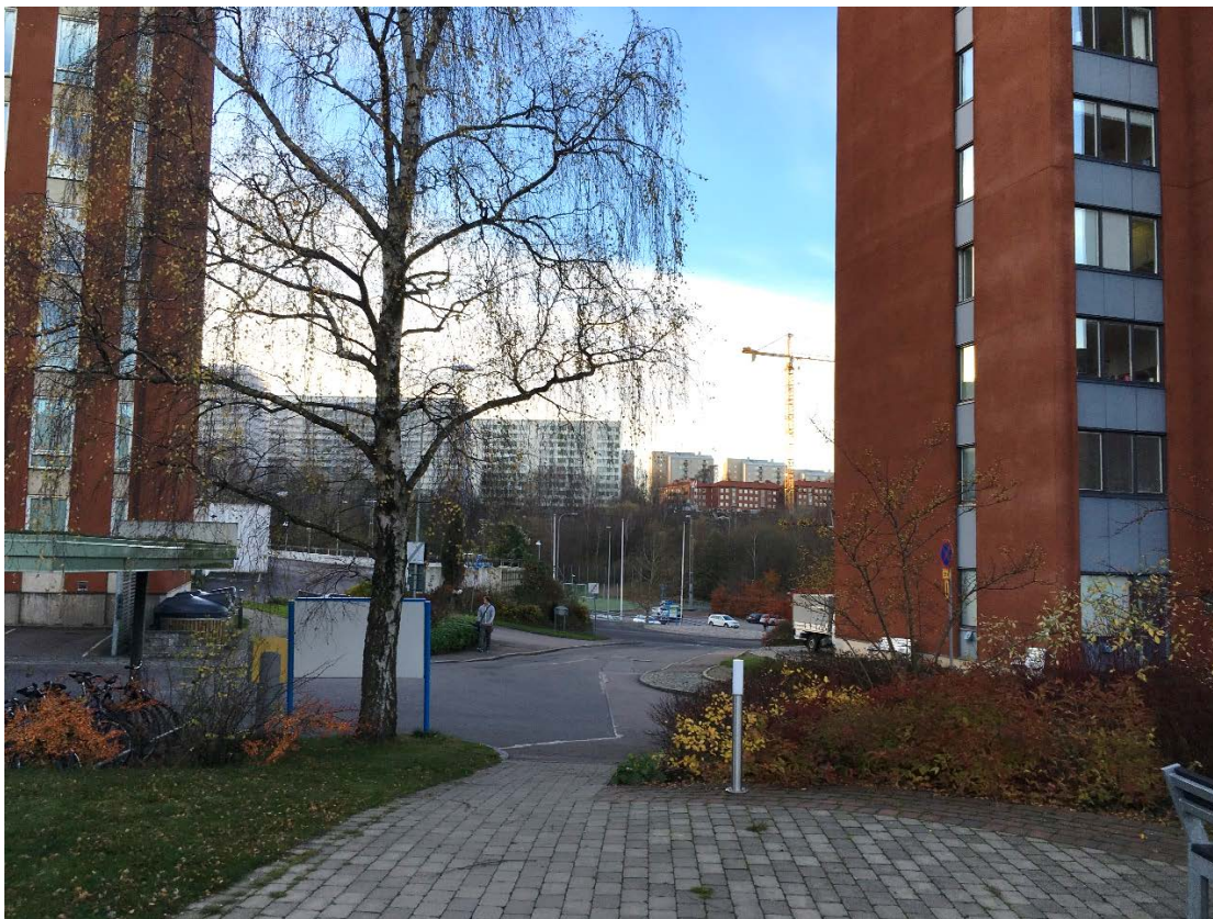
Bilden visar kommande byggplats inifrån området med utblickar.
