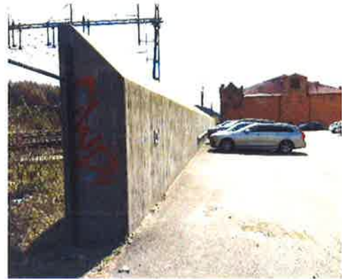
Till vänster Sektion över föreslaget läge på skyddsmur mot avåkande tåg samt till höger foto på liknande skyddsmur utmed järnväg söderut inom f.d. Lyckholms fabriker.
