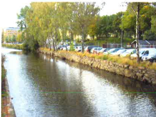
Mölndalsån, norra delen av området, vy från norr med stenmur väster om ån.
