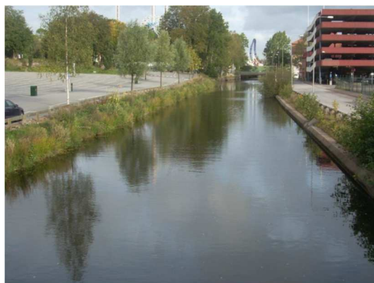
Mölndalsån, södra delen av området, vy från söder med naturlig slänt väster om ån och stödmur öster om ån.
