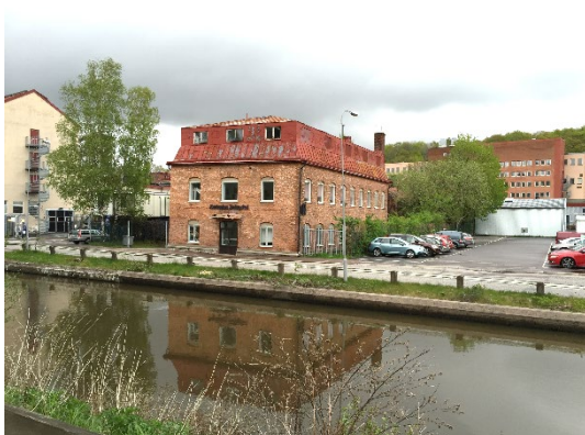
Angränsande befintlig bebyggelse öster om Nellickevägen
