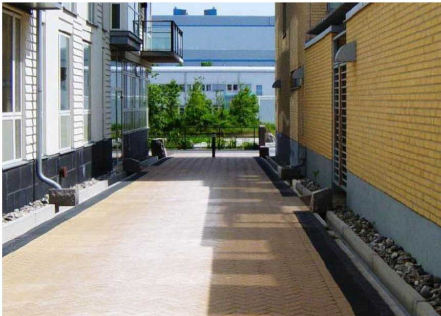
Figur 3. Stuprören ansluter till rännor för avledning av takvatten. Källa: www.vasyd.se .
