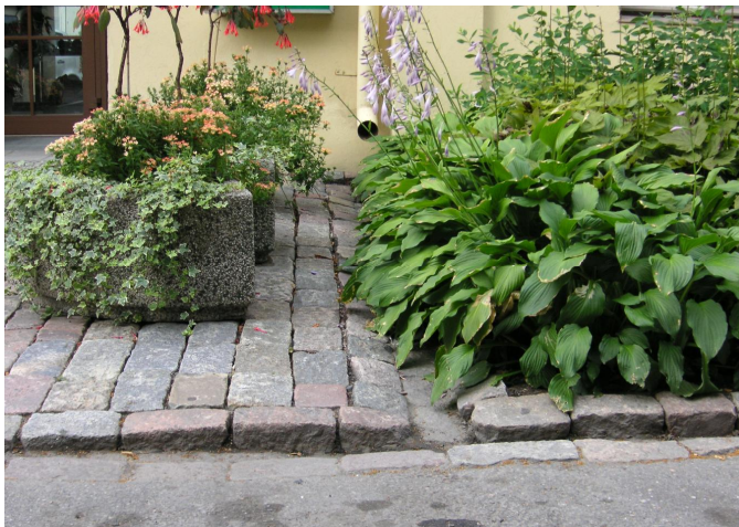
Figur 8. Stuprörsutkastare som avleder dagvatten ytligt.
