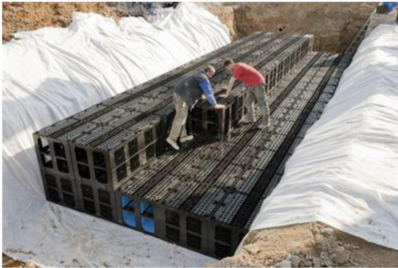
Figur 9. Visar montering av kassetter för dagvattenhantering med geotextil. Källa: www.rehau.com
