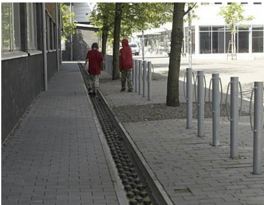
Figur 4. Gångarna mellan husen kantas av rännor i betong med bulor på botten.
