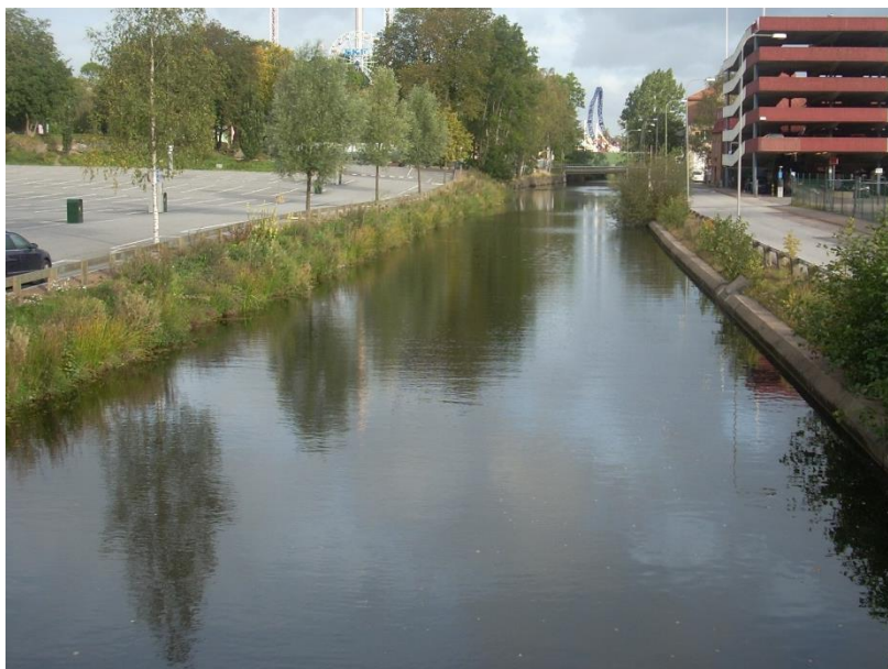
Bild 5.2 Mölnålsån, södra delen av område, vy från söder med naturlig slänt väster om ån och stödmur öster om ån.
